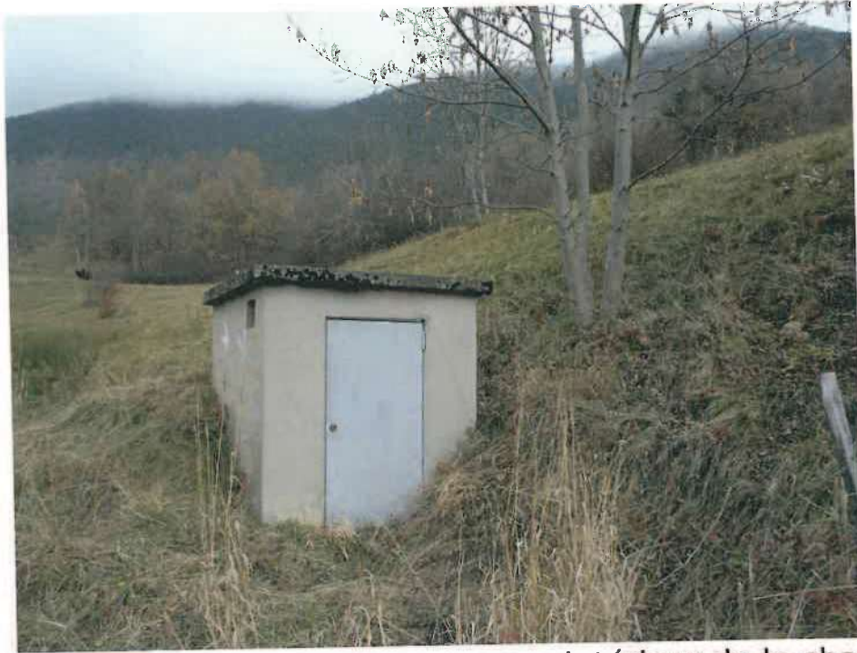
la chambre de captage
